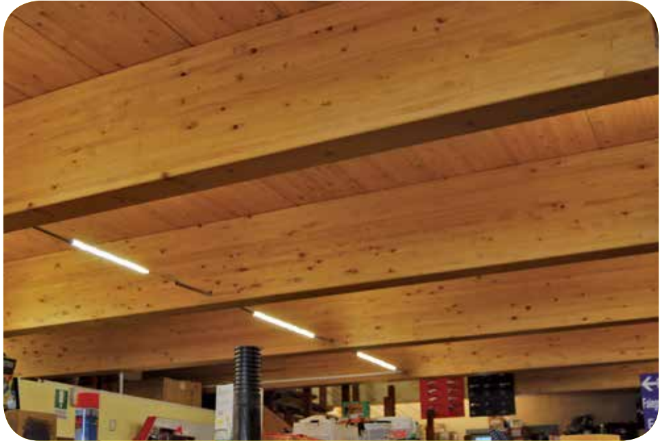
L.N.T.Trade srl, Bronte (CT) Solaio in legno
