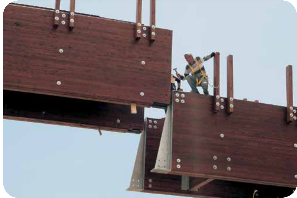
Santa Teresa di Riva (ME) Ponte sul torrente Agrò e gazebi di ristoro
