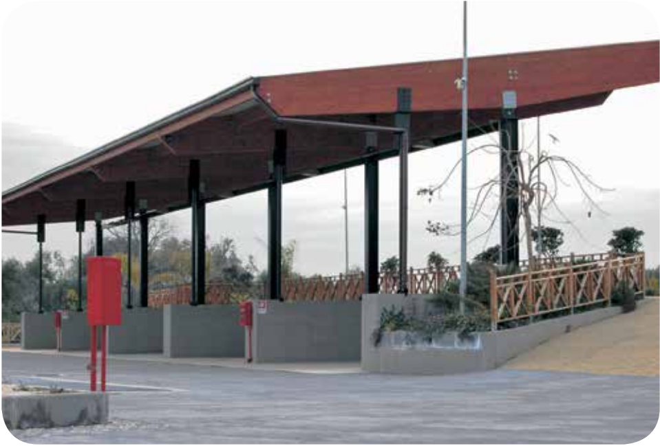
Tettoia industriale - S. A. Li Battiati (CT)
