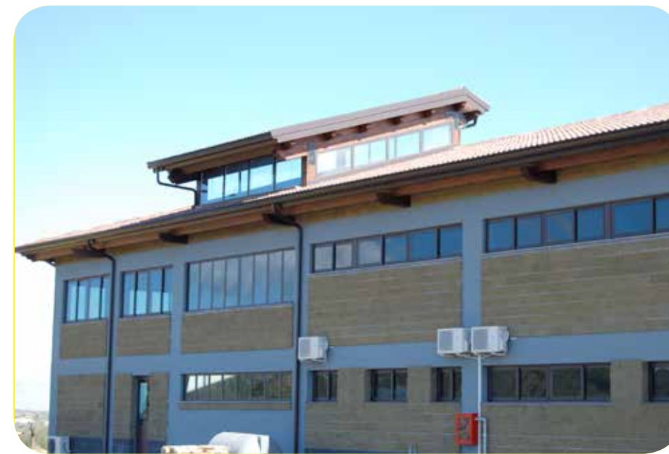
Uffici privati, Sortino (SR) Copertura in legno lamellare
