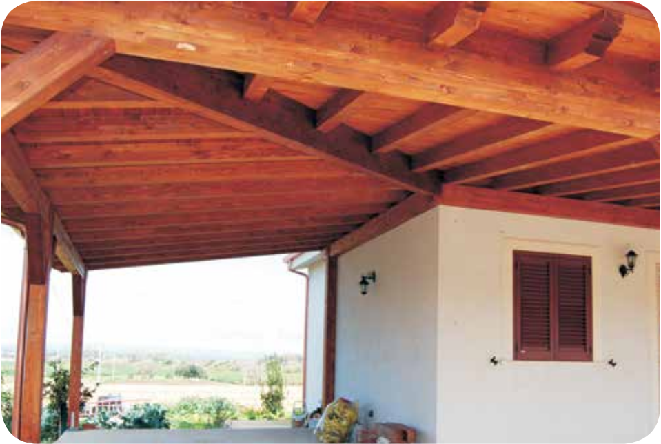
Villa privata, Marzamemi (SR) Tettoia in legno lamellare
