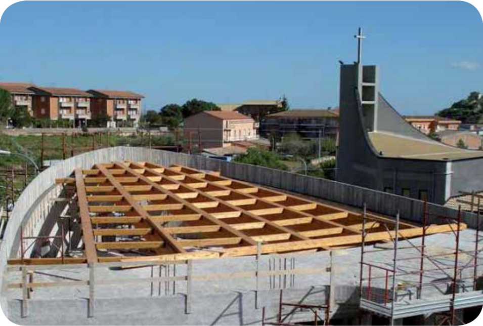
Chiesa, Assoro (EN) Copertura in legno lamellare
