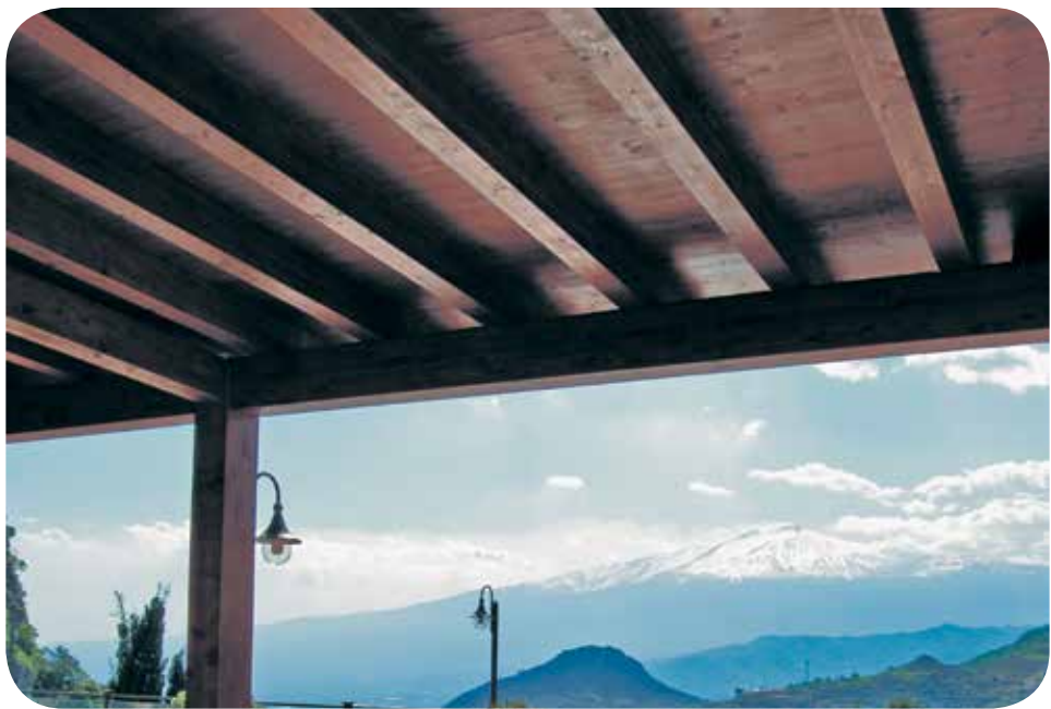
Hotel Villa Sonia, Castelmola (ME) Copertura in legno lamellare
