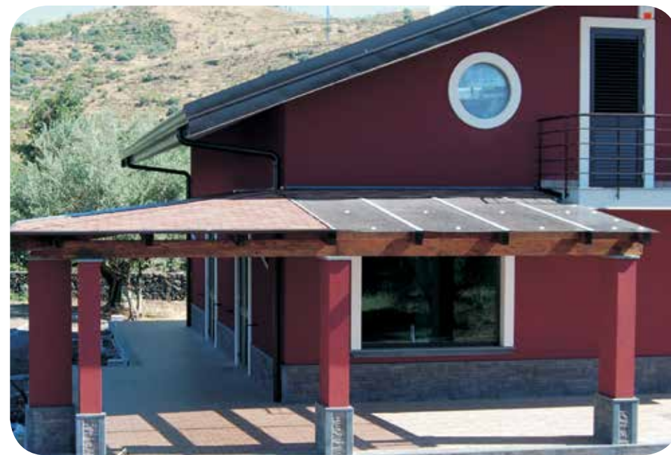
Villa privata, Bronte (CT) Tettoia in legno e polycarbonato
